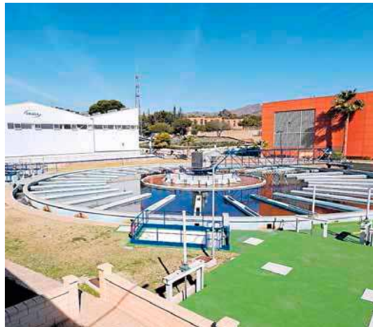
Instalaciones de Emasa en el Atabal. MIGUE FERNÁNDEZ
